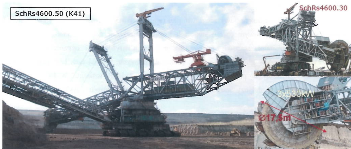
Rys. 1. Przykładowe obiekty badań, na których wnioskodawca zrealizował metodę identyfikacji i ograniczania przeciążeń napędów głównych i ustroju nośnego: SchRs4600 KWB Bełchatów K41, K42 i K43
